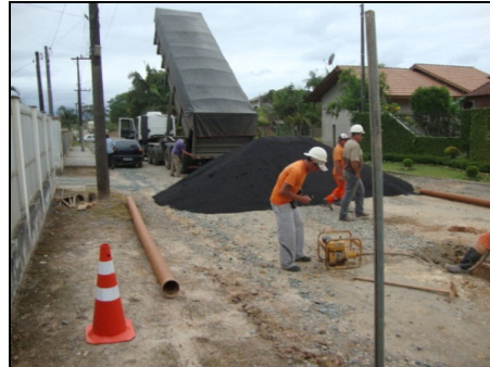
Figura 07. Transporte da ADF até o Local de Construção do Trecho.
