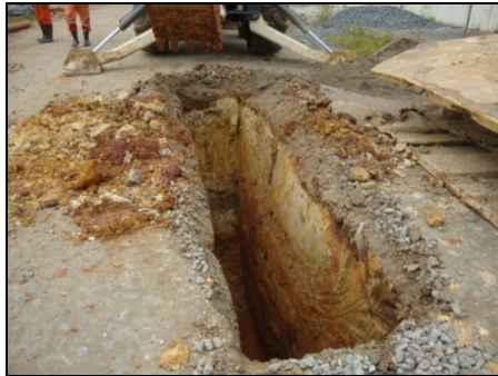
Figura 06. Abertura da Vala de Esgoto.
