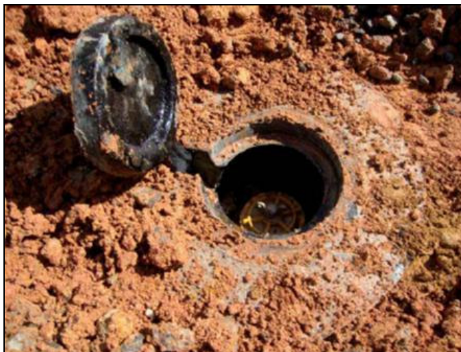
Figura 02. Acabamento do Poço de Monitoramento 04.
