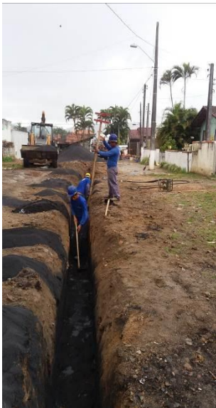
Figura 5: Preparação do berço de areia para assentamento da tubulação.
