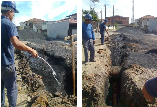
Figura 7: Reaterro de vala com adensamento hidráulico.
