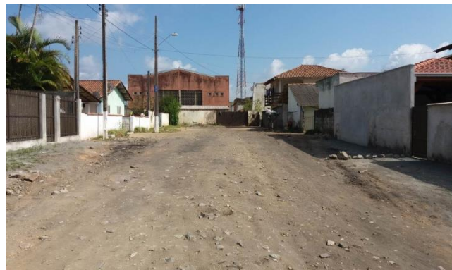
Figura 8: Trecho experimental executado com ADF.
