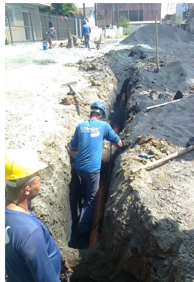
Figura 6: Assentamento da Tubulação.
