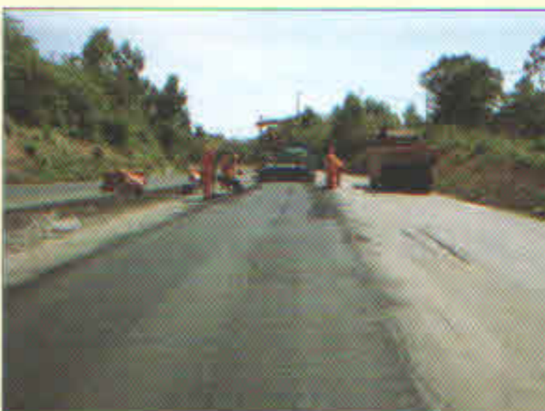
Asfalto entre Caxias do Sul e Flores da Cunha (RS), feito com ADF da Voges Fundição (Foto: Marciano Giordani)
